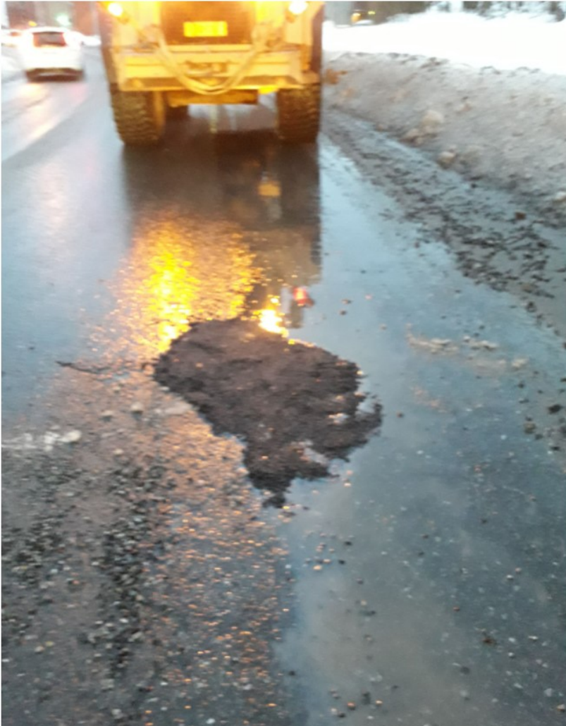
Liite 3. Päällystevaurio paikattu
